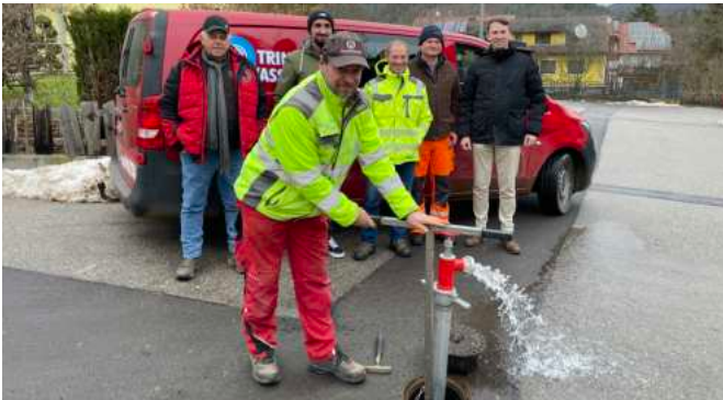
Erfolgreiche Abnahme der Baumaßnahme.
