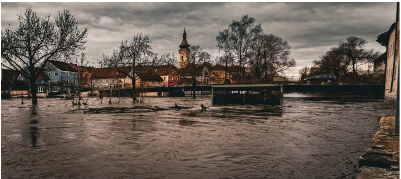
Während des Hochwassers mussten auch die beiden Regenbrücken gesperrt werden.
