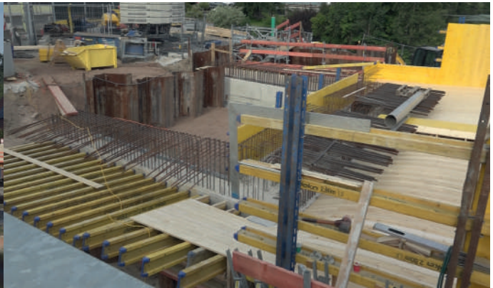
Herstellung und Hinterfüllung Widerlager
