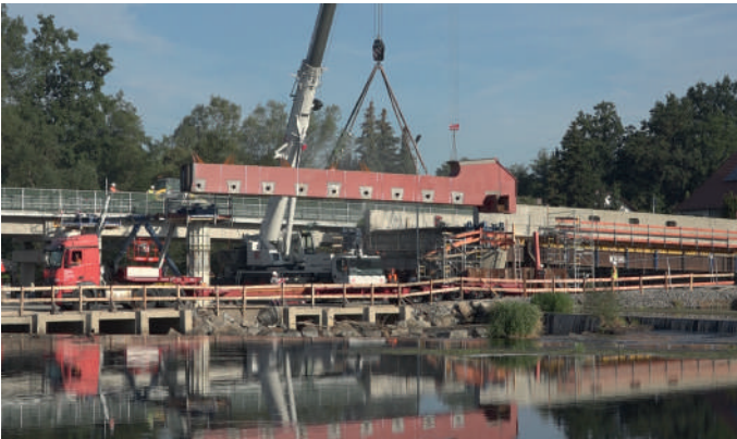
Stahlbau Montage Querträger
