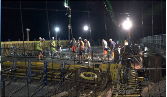
Herstellung und Hinterfüllung Widerlager
