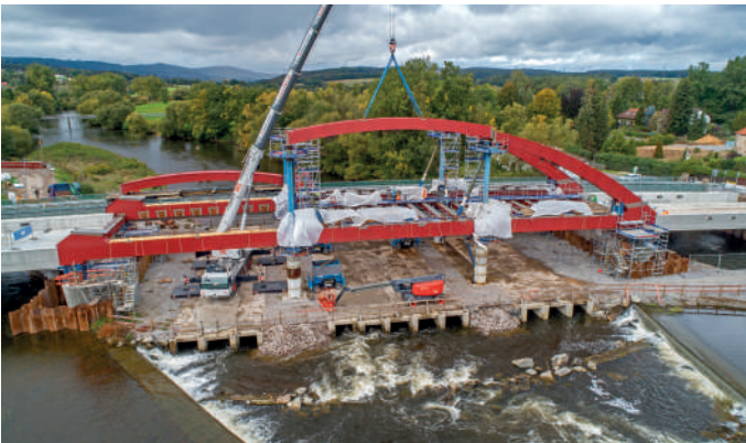
Einhub und Montage Stahlbögen
