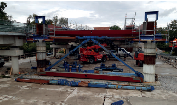
Einhub und Montage Stahlbögen
