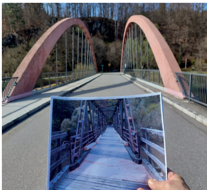
Die Brücke Überfuhr vor und nach dem Neubau.
