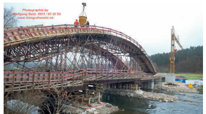
Beim Bau der neuen Brücke aus dem Jahr 2012.
