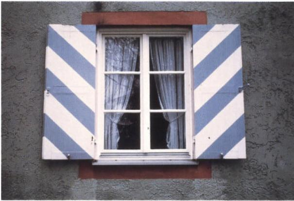
Eigentlich durch nichts zu ersetzen: Das zweiflügelige Fenster mit glasteilender Sprosse.
